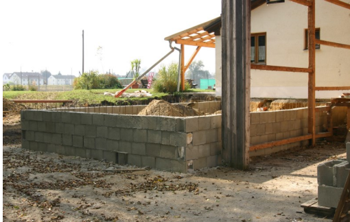
Errichtung der Grundmauer am 23.10.2010...
