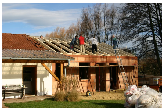
Dachstuhl und -schalung wurden am 13.11.2010 fertig gestellt.
