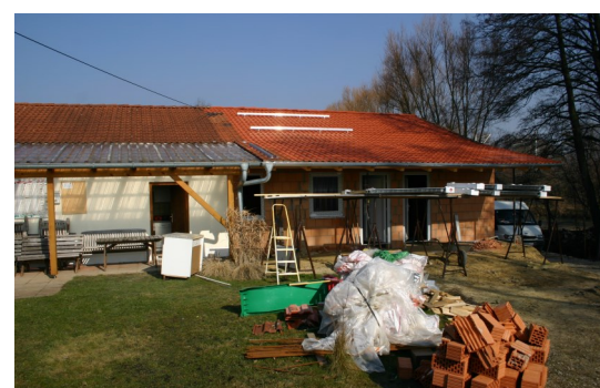
So konnte noch vor dem Winter das Dach eingedeckt werden.
